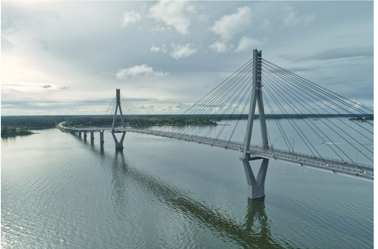
Raippaluodon silta. Kuva: Antti Kuusiniemi.
