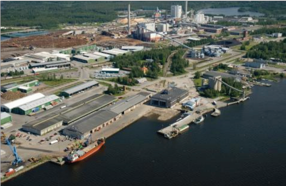
Bild 2.6. Jakobstads hamn (Källa: Jakobstads hamn).
